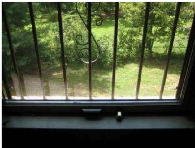
Les barres ne doivent pas être espacées de plus de 15cm. Elles seront ancrées dans le mur à l'extérieur de la maison, ou boulonnées sur des chevilles, la première solution étant la meilleure. Dans la seconde hypothèse, les têtes de boulons devront être limées une fois installées, pour empêcher le dévissage.
